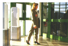
Controles de acceso y seguridad
